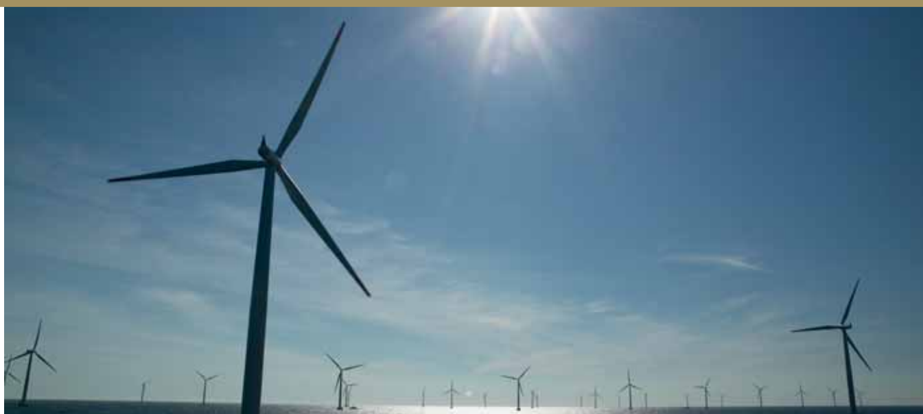
Havvindmølleparken ved Rødsand består af 72 havvindmøller, som samlet har en effekt på 165,6 MW.
